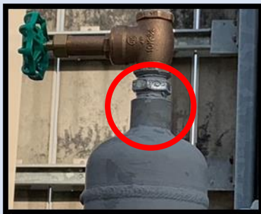
(↑)キャップにボスを溶接
